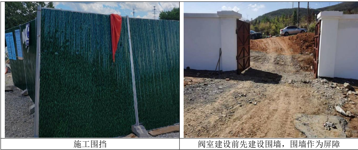
图 7.1-1 施工期废气污染防治措施落实情况
