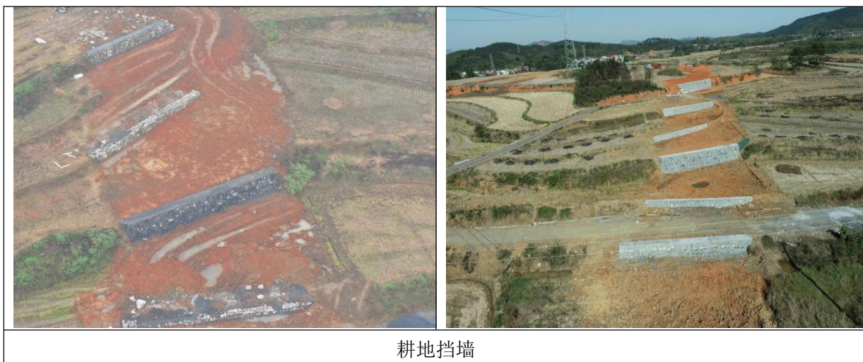
图 5.3-2 水土保持措施落实情况
