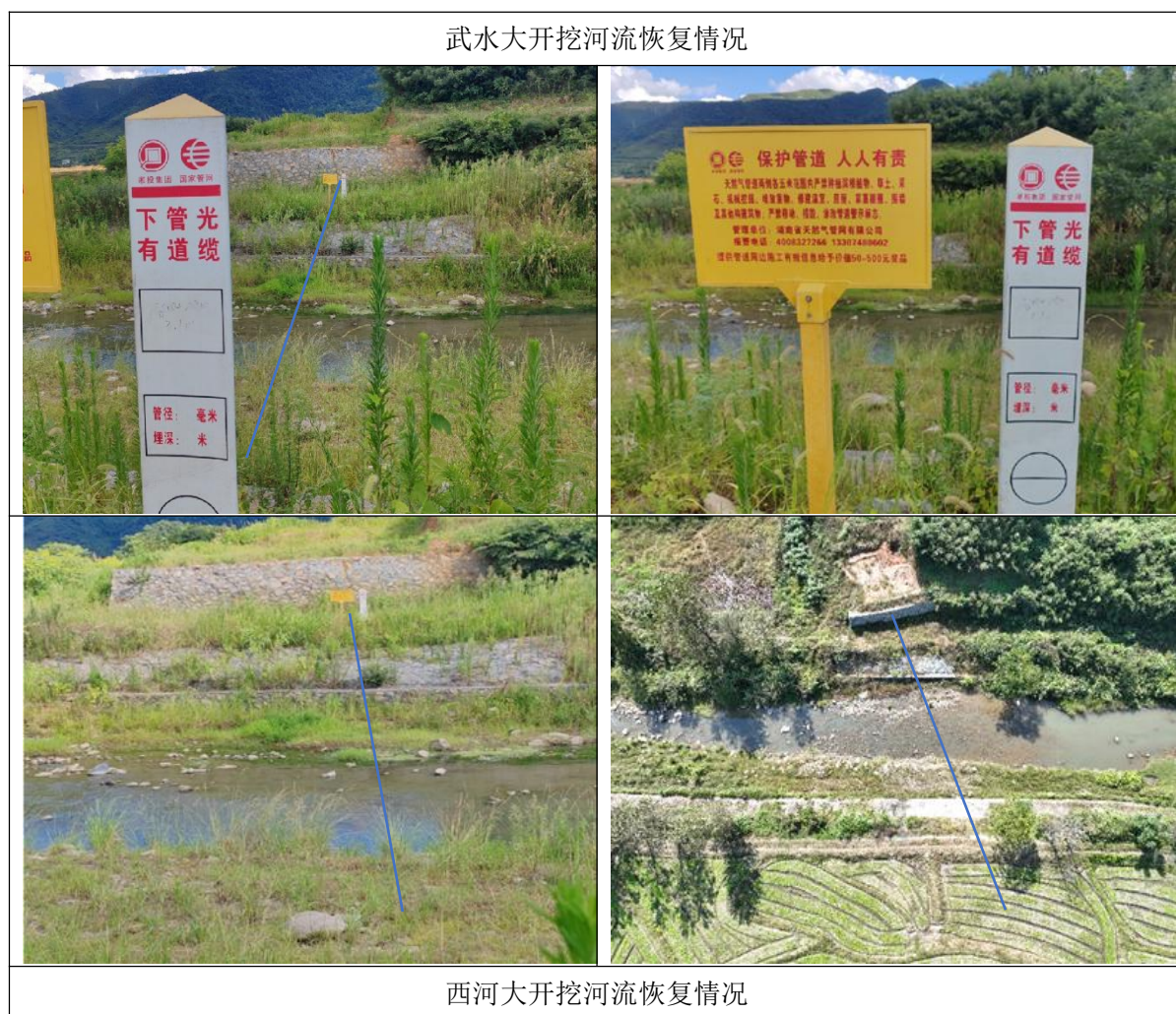
图 6.1-1 大开挖穿越河流段恢复照片
