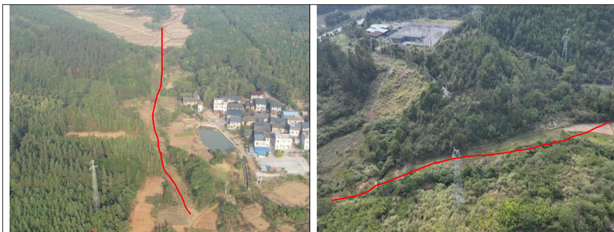
图 5.1-6 林地恢复情况照片
